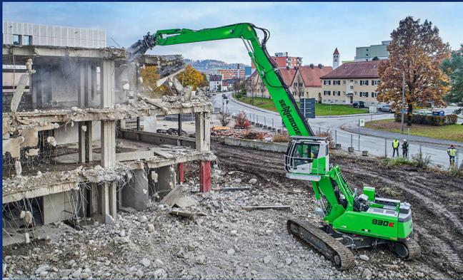
La machine de démolition hydraulique compacte SENNEBOGEN 830E HDD permet le démontage et les travaux de démolition, même dans des espaces restreints. Ce multitalent se distingue par ses dimensions compactes, surtout sur les chantiers urbains. Cette machine est flexible pour le tri et le chargement des matériaux.
